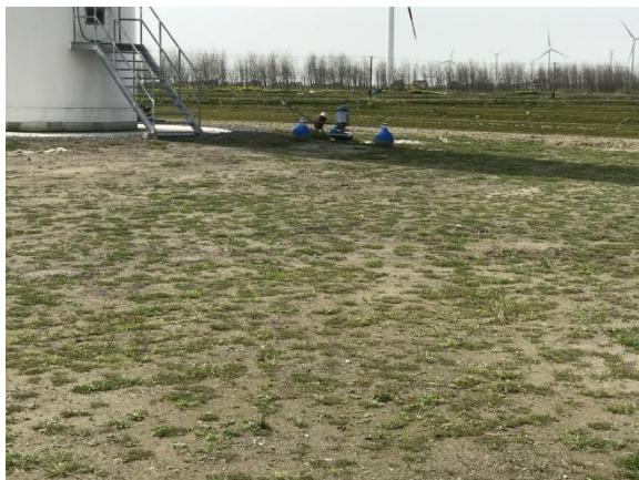
图 1 风机及箱变区
